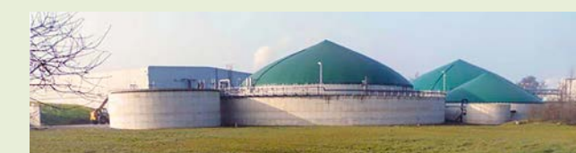
Digrom, Ardoe: een biogasinstallatie die gebruik maakt van organische reststromen uit de groente verwerkende industrie
