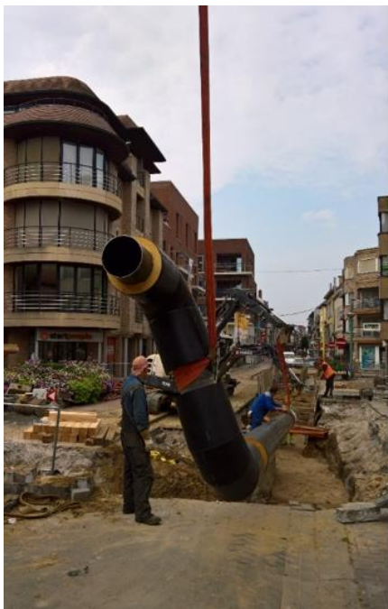
Figuur 10: Aanleg warmtenet bij MIROM
